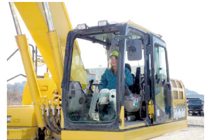
女性でも大型重機を取り扱う技術者が増えている
